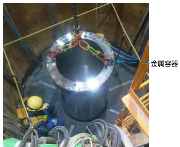
金属容器を設置している様子
